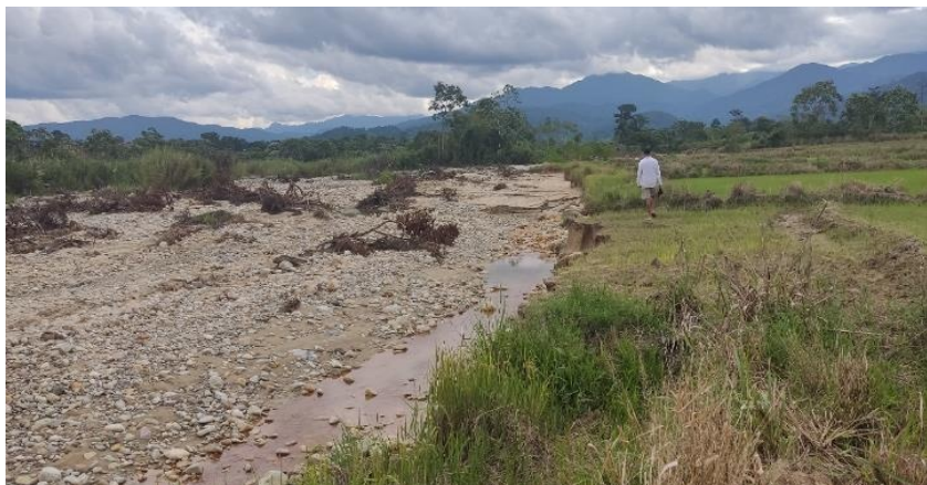
FIGURA N°02: TRAMO DONDE NO SE APRECIA BIEN EL CAUCE DEL RIO SANTA MARTHA, DEBIDO AL MATERIAL COLMATADO
